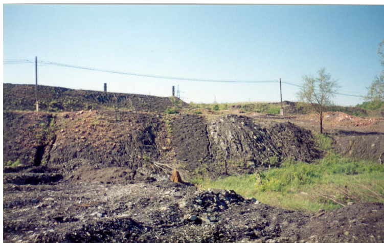
Рисунок 4 – Террасированная поверхность, сложенная отработанной породой. На склонах – проявления струйчатой эрозии (фото К. Акпамбетовой)
