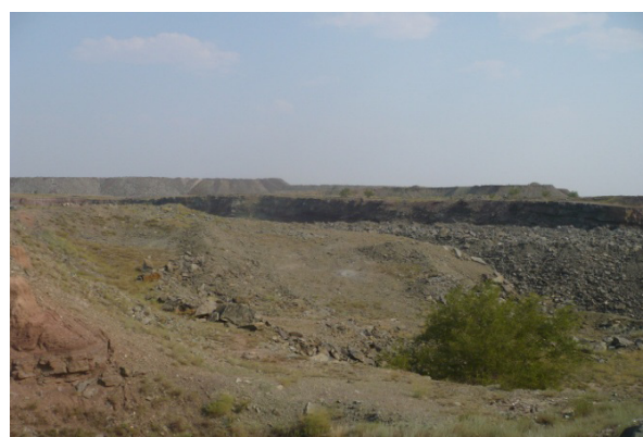
Рисунок 1 – Провалы над шахтными пустотами (близ пос.Рудник. Жезказганское рудное поле)
