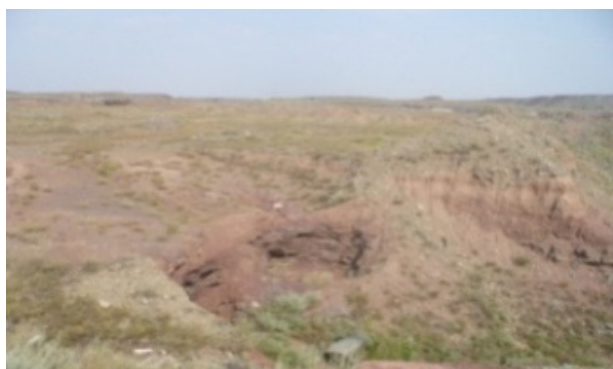
1-сурет – Бос шахталар үстіндегі опырылымдар (Рудник ауыл маңы, Жезқазған рудалық аймағы)
