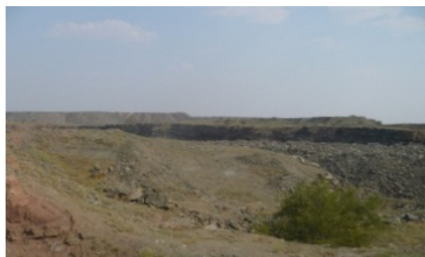
1-сурет – Бос шахталар үстіндегі опырылымдар (Рудник ауыл маңы, Жезқазған рудалық аймағы)
