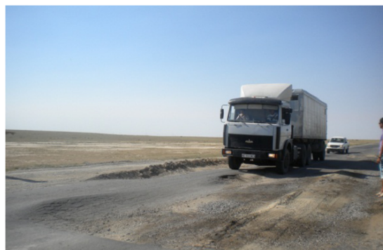
3-сурет – Құлсары-Теңіз трассасындағы жолдың деформациясы (жерлерінің төмендеуі)
