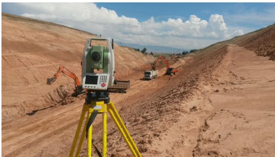
Рисунок 4 – Трассирование дороги в районе месторождения Жанажол
